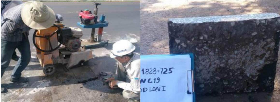
Công tác khoan cắt mẫu BTNC19
