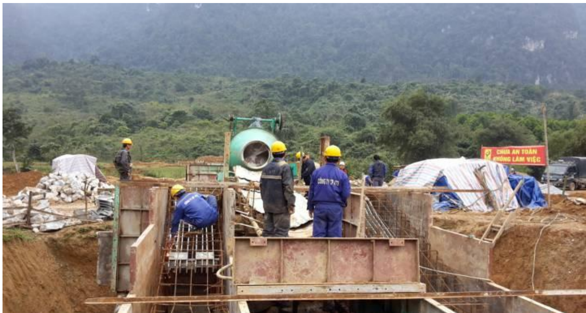
Đổ bê tông móng neo cầu Tăng Hóa, xã Hóa Sơn, huyện Minh Hóa; Dự án 186 Cầu treo dân sinh
