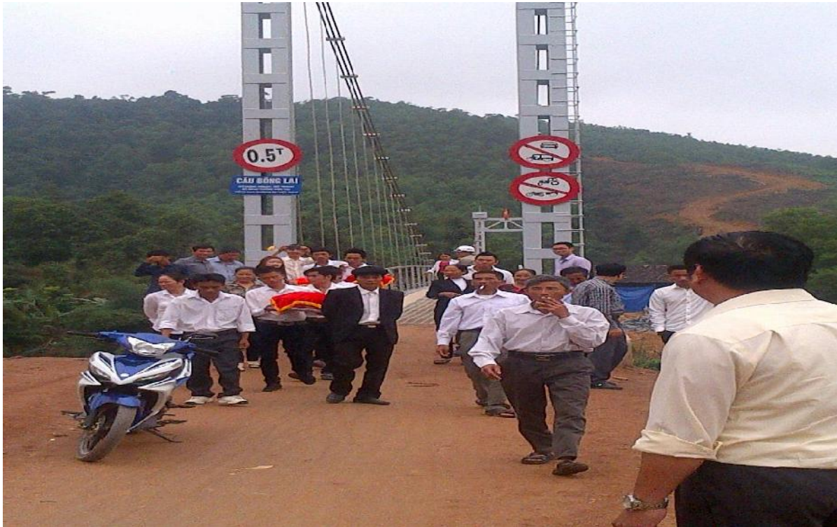
Cầu treo Bồng Lai, xã Hưng Trạch, huyện Bố Trạch, Quảng Bình Dự án 186 Cầu treo dân sinh
