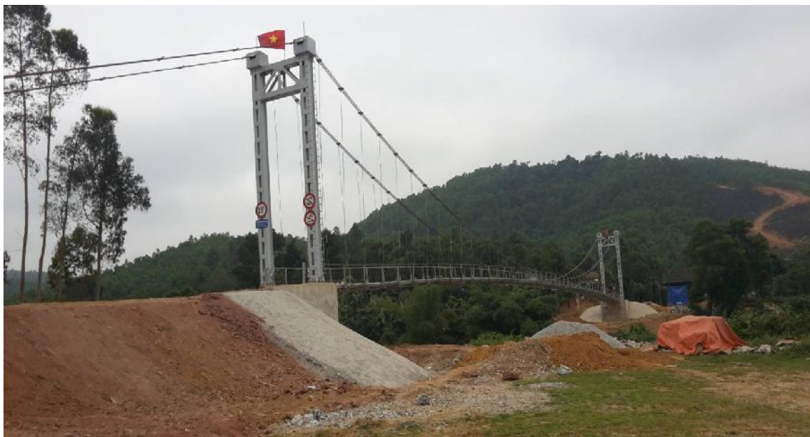
Cầu Bồng Lai, xã Hưng Trạch, Bố Trạch, Quảng Bình Dự án 186 Cầu treo dân sinh
