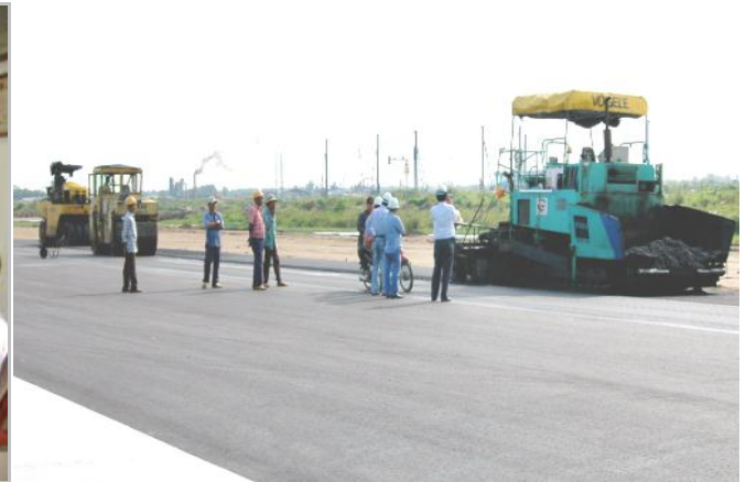
TVGS thi công bê tông nhựa polime đường hạ cất cánh Cảng hàng không Cần Thơ
