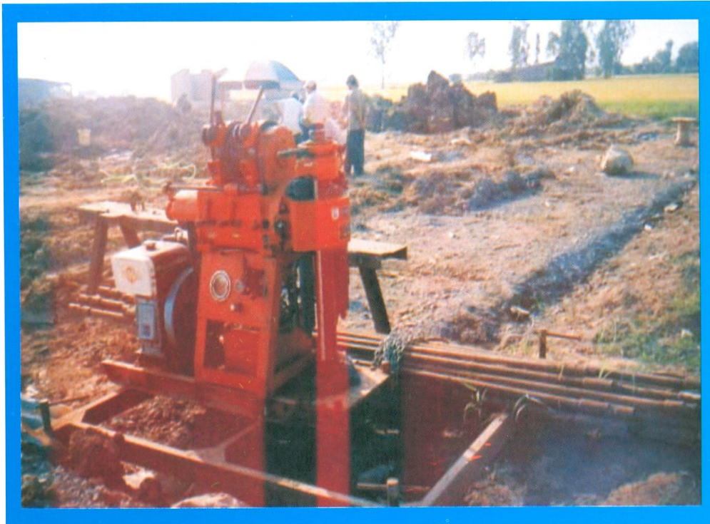
Máy khoan địa chất và khoan bê tông, mũi cọc và thí nghiệm xuyên tĩnh SPT cọc khoan nhồi
