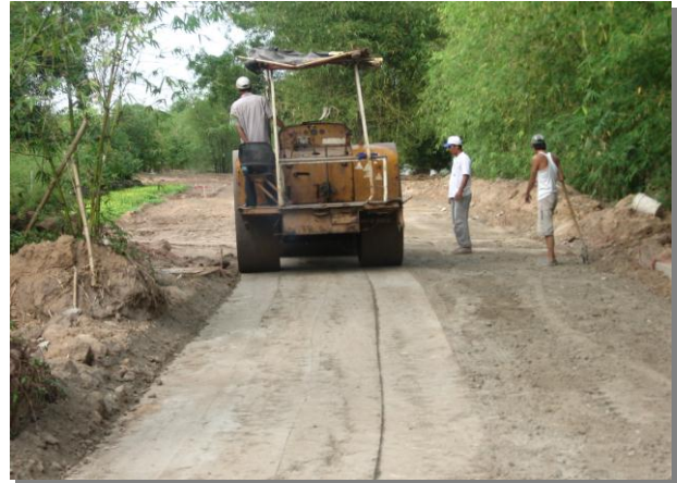
Công trình gia cố đất
