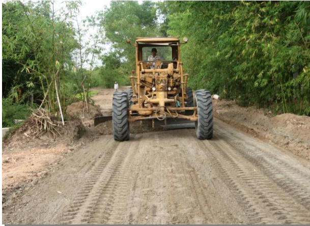
Công trình gia cố đất
