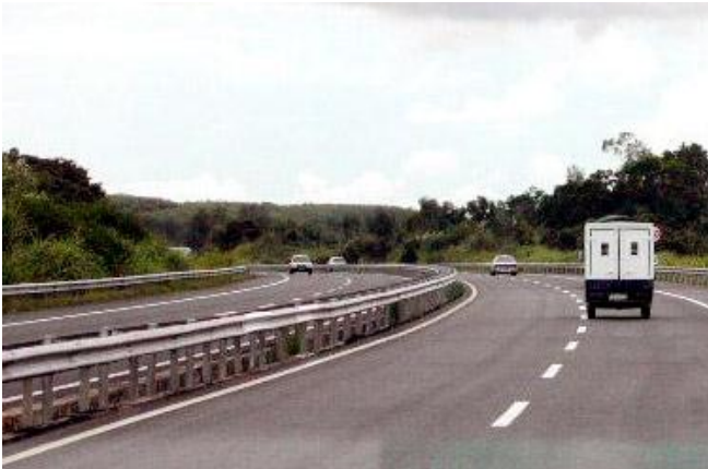
Dự án đường cao tốc Cầu giẽ - Ninh Bình
