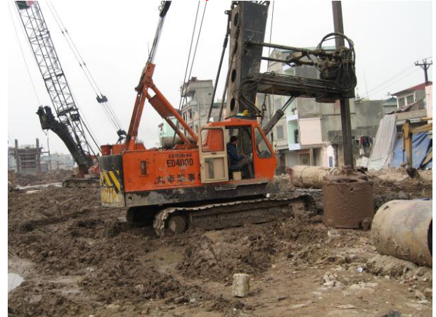
Dự án cầu Vĩnh Tuy và tuyến đường hai đầu cầu
