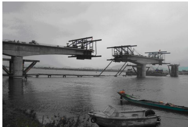
Dự án cầu Quảng Hải – Quảng Bình
