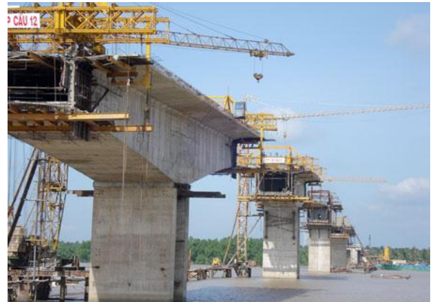
Dự án xây dựng cầu Hàm Luông – Bến Tre
