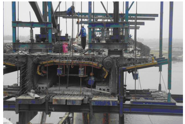
Dự án cầu Quảng Hải – Quảng Bình
