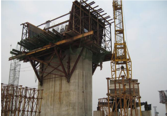
Dự án cầu Vĩnh Tuy và tuyến đường hai đầu cầu
