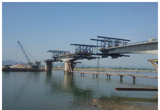
Dự án xây dựng cầu Văn Hóa
