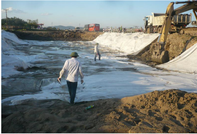
Dự án nâng cấp, mở rộng Quốc lộ 1A
