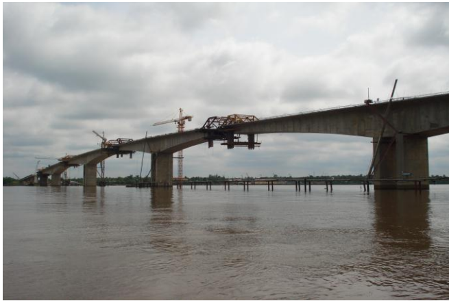
Dự án xây dựng cầu Hàm Luông – Bến Tre
