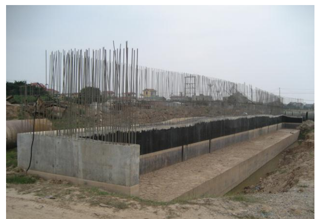
Dự án cầu Đông Trù
