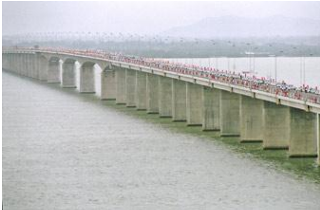
Dự án cầu vượt Đầm Thị Nại – Bình Định
