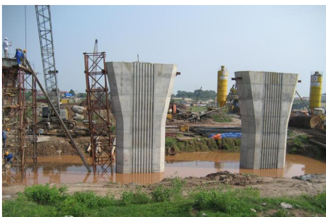
Dự án cầu Đông Trù
