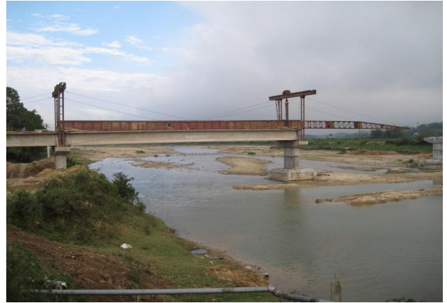
Dự án đầu tư xây dựng 10 cầu trên tuyến Đ. 837
