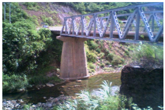
Công trình cầu Khe Ve – tỉnh Quảng Bình
