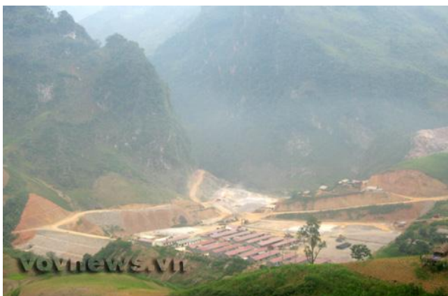
Công trình Thủy điện Nho Quế - tỉnh Hà Giang
