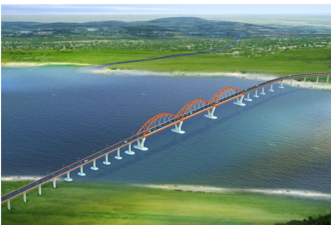
Dự án xây dựng cầu Mỹ Lợi
