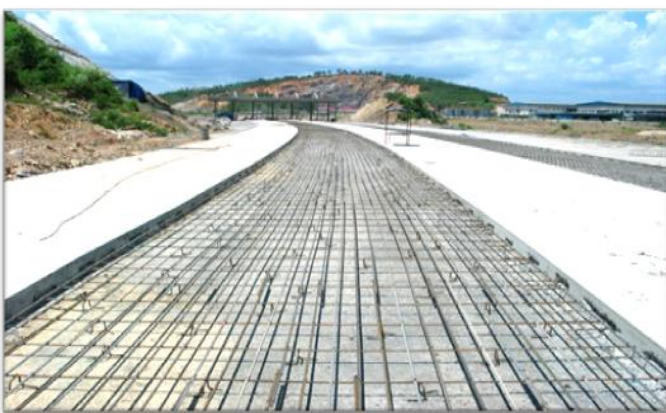
Hình 5. Thiết kế, chuyển giao công nghệ mặt đường BTXM cốt thép liên tục (CRCP) tại TTP cầu Bãi Cháy, QL18
