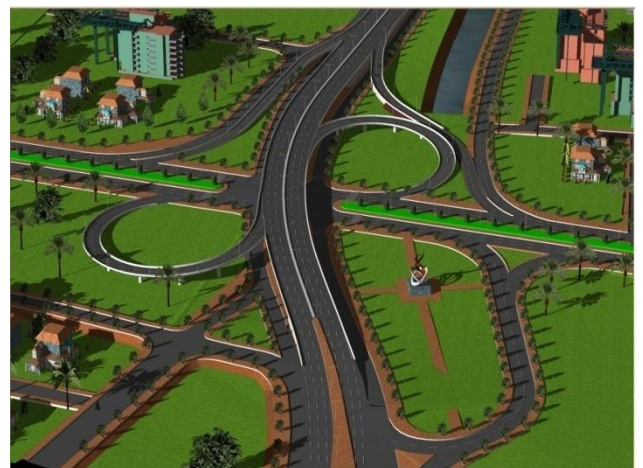
Hình 4. Một trong các phương án thiết kế nút giao thông khác mức Bưởi - TP.Hà Nội
