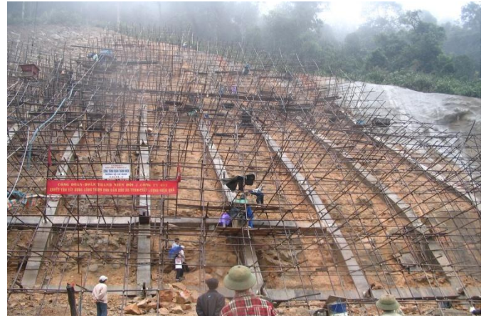
Hình 8. Ứng dụng công nghệ neo U'ST (OVM Trung Quốc) phòng chống sạt trượt đèo Đá Đẽo đường Hồ Chí Minh
