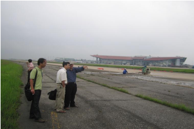
Hình 7. TVGS DA sửa chữa nâng cấp đường lăn S4, S6, S1, Cảng HKQT Nội Bài
