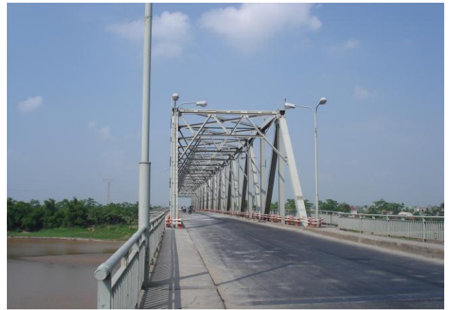
Bảo vệ cầu Phong Châu bằng hệ sơn 10 năm
