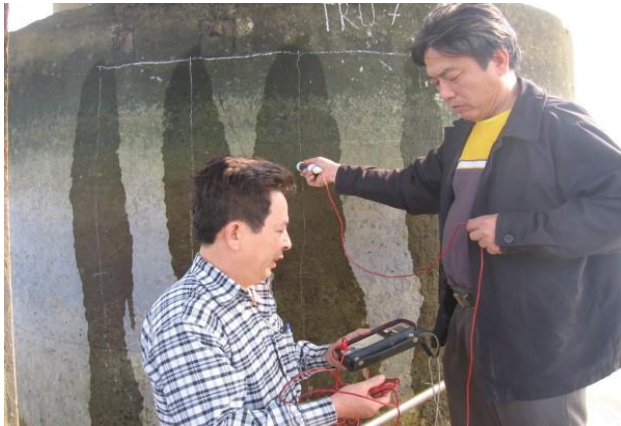
Khảo sát cầu bến thủy
