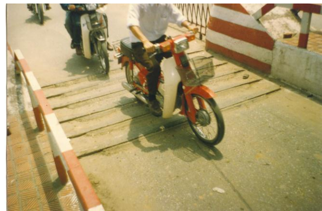
Ứng dụng Bê tông, vữa Polymer PEX vào sửa chữa và gia cố đoạn đường trong điều kiện không làm ngừng giao thông
