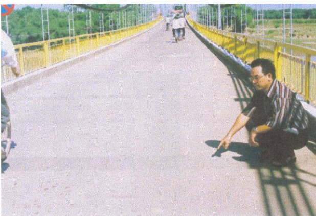
Ứng dụng Bê tông, vữa Polymer PEX vào sửa chữa Cầu Dừng - Nghệ An
