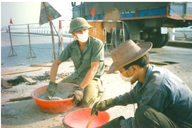
Thi công chống thấm và sửa chữa mặt Cầu Gián Khẩu trên Quốc lộ 1A cũ bằng vật liệu PEX
