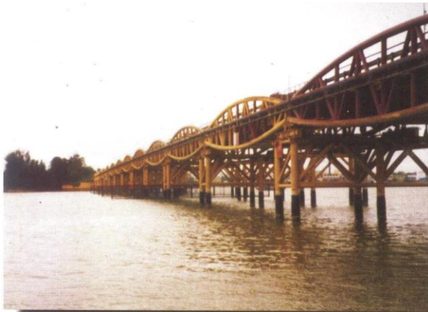
Bảo vệ cầu Nguyễn Văn Trỗi bằng hệ sơn cao su clo hóa (khu vực khí quyển), hệ epoxy pek
