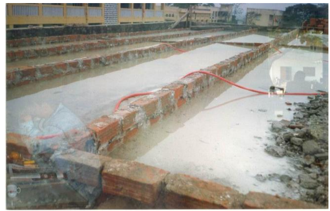
Ứng dụng vật liệu PEX để chống thấm mái nhà cao tầng (thử nghiệm kiểm tra sau chống thấm Trường Nguyễn Viết Xuân – Hà Nội)
