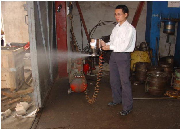
Phương pháp thi công bằng công nghệ phun tạo màng
