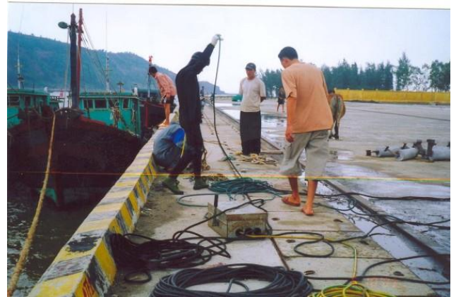
Lắp đặt a nốt hy sinh tại cảng số 1 - vietsopetro
